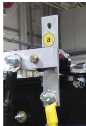
МЕДНЫЕ ИЛИ АЛЮМИНЬЕВЫЕ, ВЫВОДЫ НН ДЛЯ AKELCAST ST
