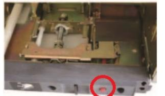
• Блокировка положения автоматического выключателя в корзине «отключение» выкатного автоматического выключателя
