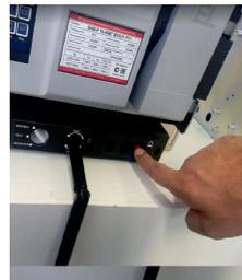
Вставляем рукоятку в гнездо привода и зажимаем блокировку
