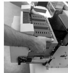
Берёмся за ручки на выключателе и снимаем его с направляющих вертикально вверх
