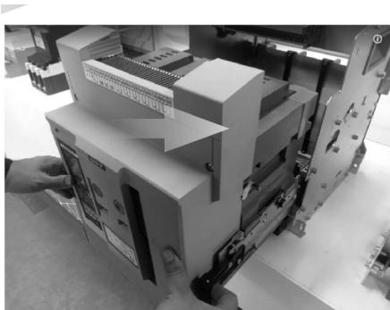
Тянем выключатель на себя до тех пор пока выключатель полностью не выйдет из корзины
