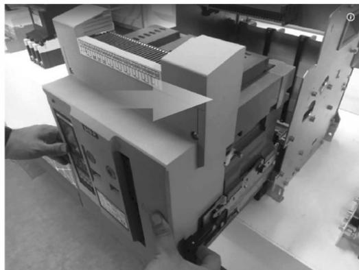
Тянем выключатель на себя до тех пор пока выключатель полностью не выйдет из корзины
