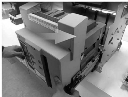
Тянем аппарат на себя до тех пор пока он полностью не выйдет из корзины и будет держаться только на выкатных направляющих корзины
