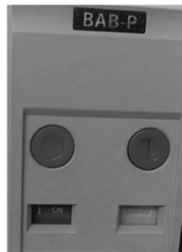
Выключатель включен, пружина не взведена
