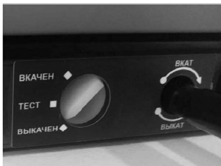
Указатель в положении «Выкачен»
