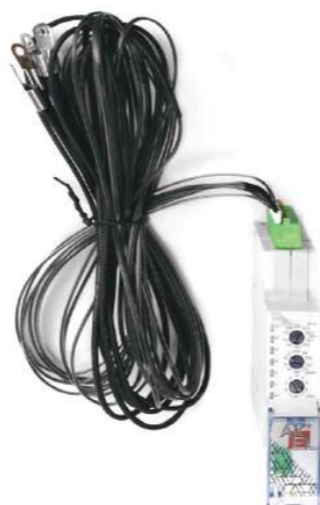
Модуль измерения температуры ошиновки
